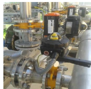
Затворы на газ в антистатическом исполнении с концевыми выключателями
